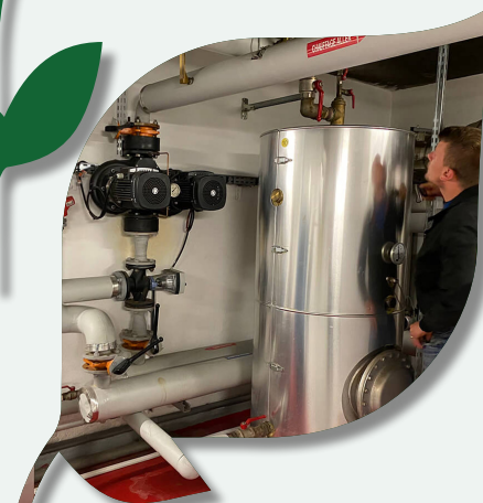
Changement de chaudière chauffage
